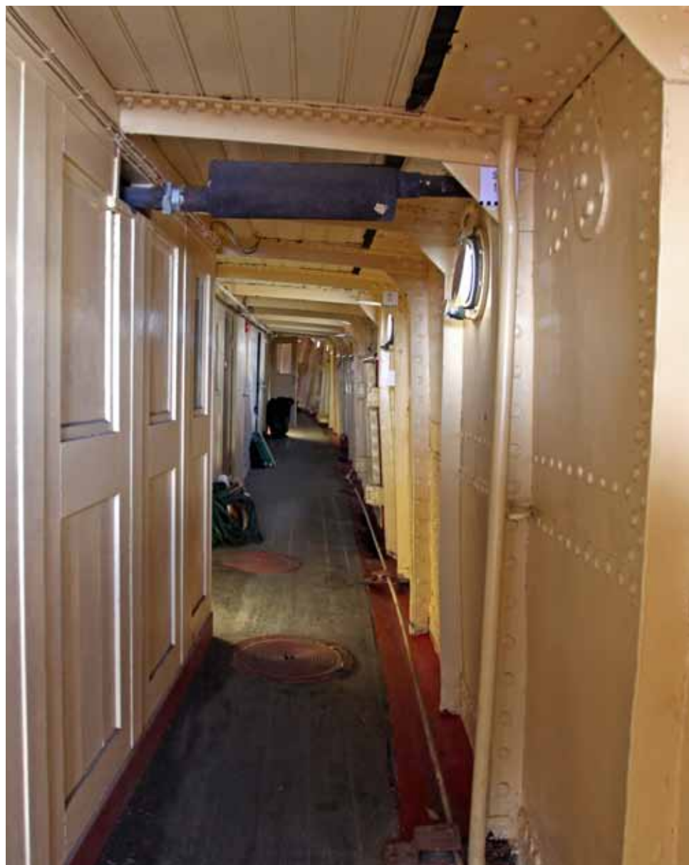
Styyrpuurin puoleinen käytävä (205) kuvattuna kohti keulaa. Osa viereisten tilojen sisäikkunoista on alasaranoituja ja avattavia.
