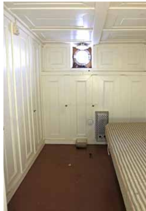
Museohytti (106) on rakennettu vuosien 1987–1988 aikana. Seinä- ja kattopinnat ovat paneloitua koivuvaneria.
