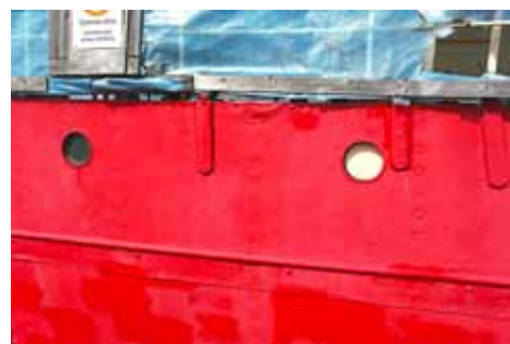
Pääkannen käytävän (203) pyöreitä venttiili-ikkunoita paapuurin puoleisessa kyljessä.
