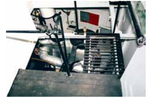
Kunnostustöiden yhteydessä vanhat kulkusillat poistettiin ja lisättiin teräksinen tikasporras, joka johtaa pääkannen tasosta alas konehuoneeseen. Näyttelyvieraat näkivät alas konehuoneeseen oikealle asennetun akryylilevyn kautta. Kuva on vuodelta 1988. Konehuoneen yläpuolisen tilan numero on 202. Kuva: SMK / MV.
