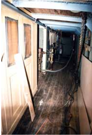
Pääkannen paapuurin puoleinen käytävä (203) kohti perää kunnostusten aikana.
