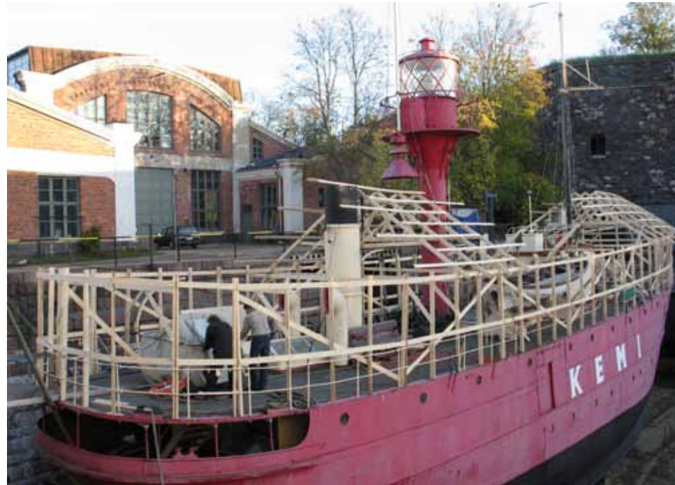
Museolaivan suojaksi rakennettiin lokakuussa 2005 Suomenlinnan kuivatelakalla suojakatos.
