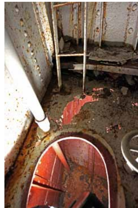
Petrolisäiliön (112) lattia on ruostunut puhki. Alempana näkyy pilssikannen keulavarasto (008). Tilojen läpi kulkee merivesiputki.
