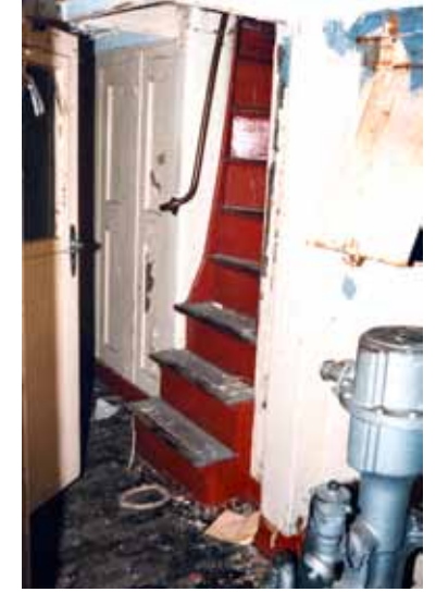
Pääkannelta ylös ruorihyttiin johtava portas kuvattuna vuonna 1987 ennen kunnostustöitä.
