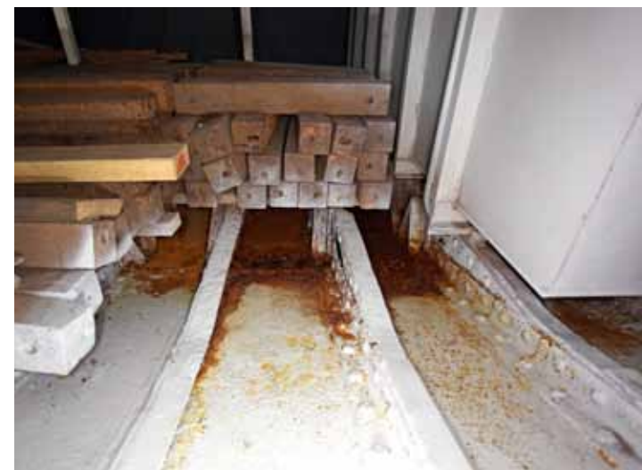
Pilssiin kertyvää vettä tyhjennetään pumpulla. Vesi pumpataan letkun kautta mereen.
