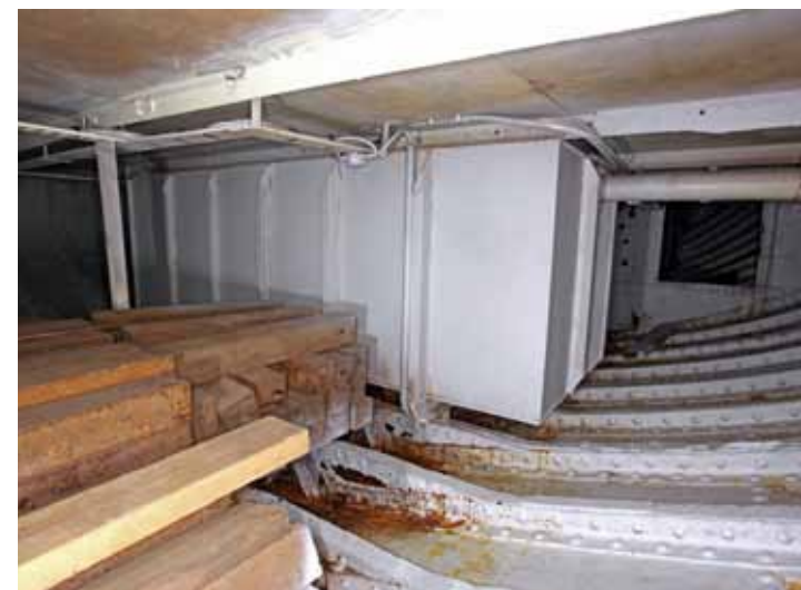
Ruuman keskiosassa on teräsrakenteinen septitankki, joka on rakennettu vuosien 1986–1988 aikana, kun yläpuolelle tehtiin tutkijoiden asuintilat, wc ja pentteri.
