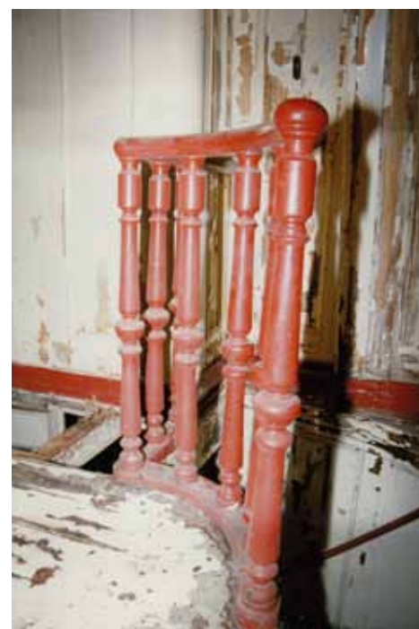
Päällystömessistä (208) hyttikannelle johtavan portaan sorvattu kaide. Kuva: SMM, käsiarkiston digitaaliset aineistot.
