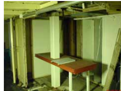
Miehistön messin seinärakenteita purettiin kantta uudistaessa. Kuva on otettu 16.1.2008.
