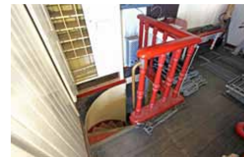
Ruorihytin (302) seinillä on vaaleaksi maalattu pystypanelointi ja valoventtiilit. Lattialla väliaikaisesti säilytettävät teräsritilät ovat skailettien suojaritilöitä.
