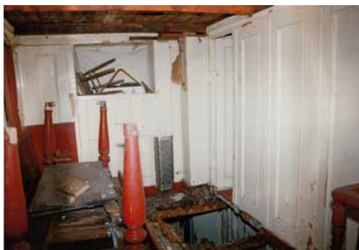
Päällystömessin (208) seinäpaneelissa näkyy vanhoja ootrauspintoja. Kuvat: SMM, käsiarkiston digitaaliset aineistot.
