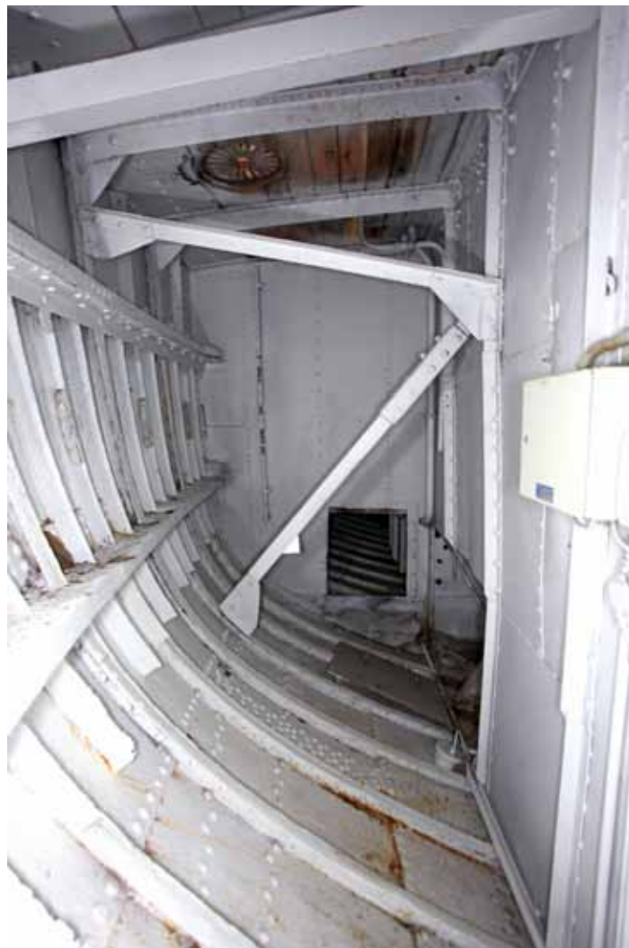
Hiilivarastot (003 ja 004) ovat lähes toistensa peilikuvia. Ne sijaitsevat höyrykattilan molemmin puolin. Kuvassa on paapuurin puoleinen varasto (003). Katossa näkyy pääkannen käytävän lattian hiilestysaukko, jossa on kuvioitu teräskansi.
