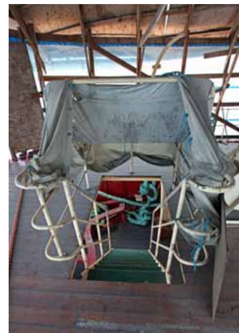
Pääkannelta sääkannelle laskeutuva teräsporras on rakennettu 1980-luvulla.
