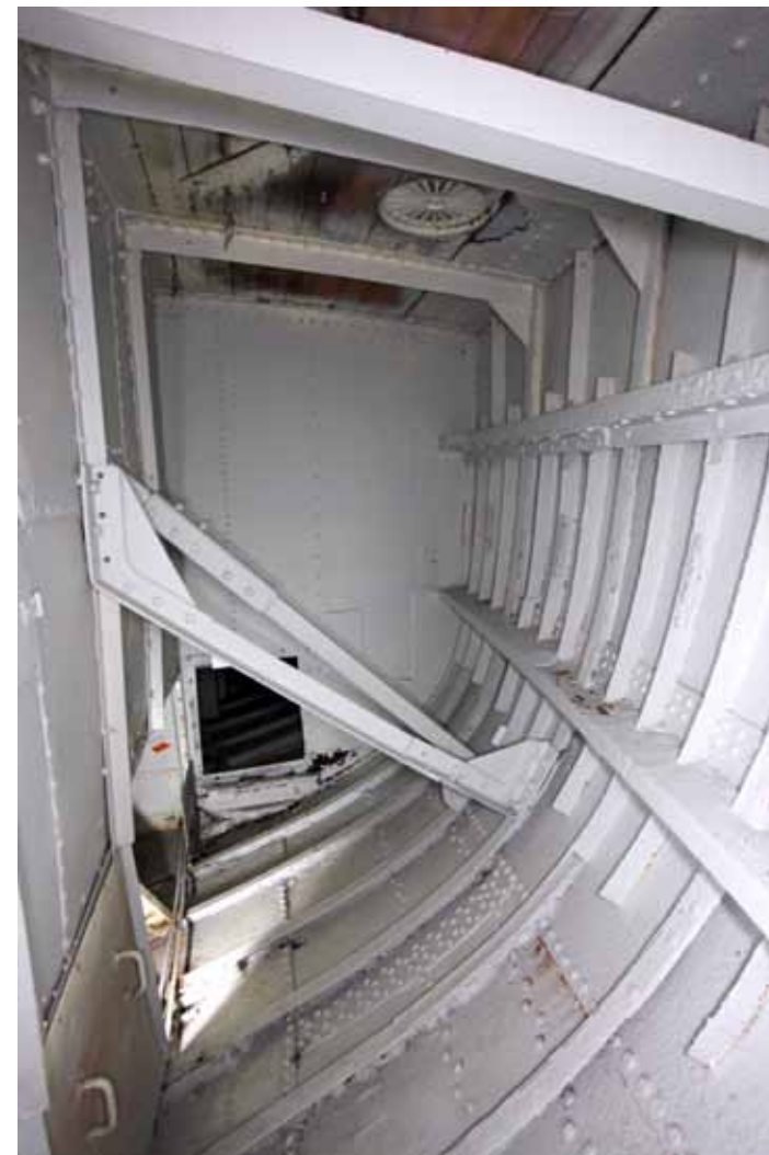
Styyrpuurin puoleinen hiilivarasto (004) kuvattuna kohti keulaa. Teräslaiption alaosassa on aukko, jota kautta pääsee ruumaan (005).
