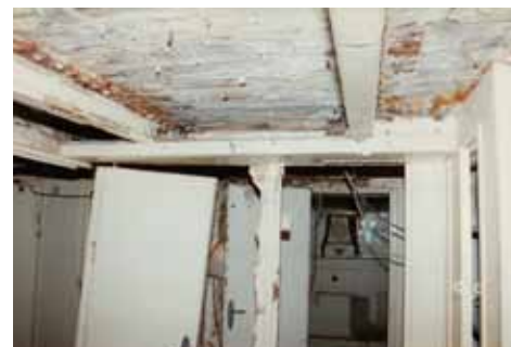
Messitytön/keittäjän hytti ja päällikön hytti korjaustöiden aikana.
