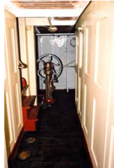
Poikittaiskäytävä (209) kunnostuksen jälkeen vuonna 1988. Pumppu-kin on kunnostettu.
