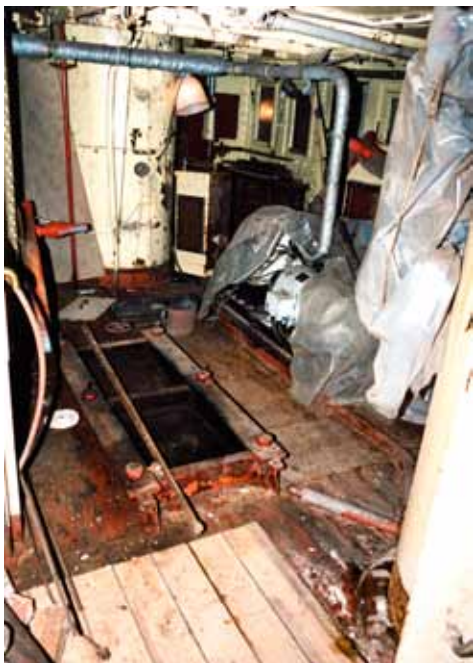
Pääkannen sähkö- ja sireenihuone (204) ennen kunnostusta vuonna 1987. Kuva: SMK / MV.
