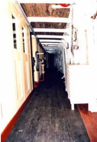
Pääkannen paapuurin puoleinen käytävä (203) kohti perää kunnostuksen jälkeen vuonna 1988.
