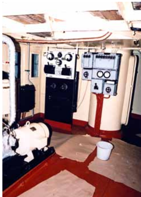
Sähkö- ja sireenihuone (204) kunnostuksen jälkeen vuonna 1988 kohti keulaa. Kuva: SMK / MV.
