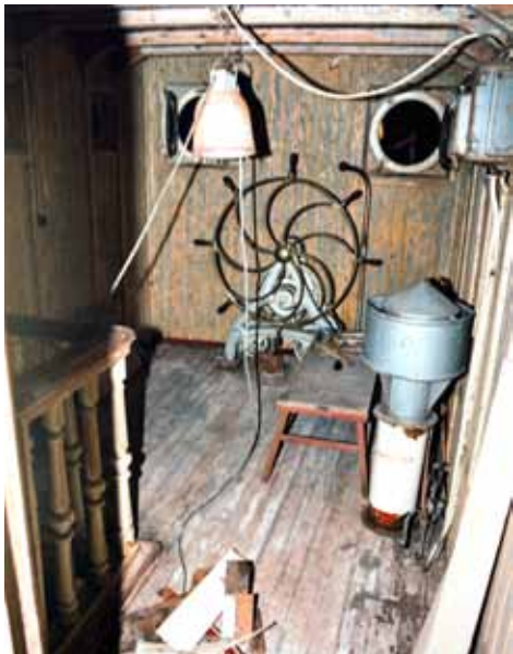
Ruorihytti (302) kunnostuksen aikana ennen uudelleen maalausta.
