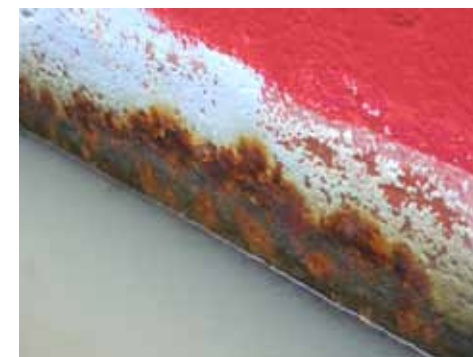
Ulkokyljen vesirajan ruostesyöpymiä.
