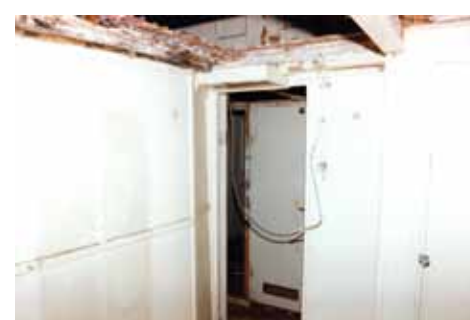
Messitytön/keittäjän hytti kohti stuurpuuria korjaustöiden aikana.
