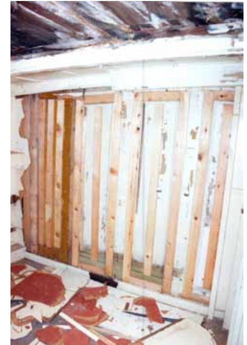
Lattialla on mahdollisesti niin kutsuttua ”rysänlevystä” eli kyllästettyä puukuitulevyä, joka oli palosuojattu eikä se imenyt kosteutta. Käsiteltäessä levy oli haurasta ja lohkeili helposti.
