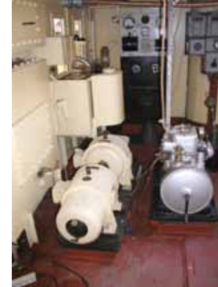
Kone- ja sireenihuone (204) kohti perää.
