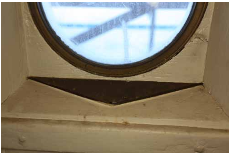
Messinkisten valoventtiileiden edessä on kaukalot, mutta vettä ei johdeta minnekään.
