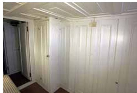
Seinät ja katto on rakennettu uudelleen koivuvanerista.
