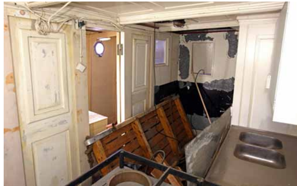
Keittiö (207) kuvattuna keulaan päin. Liesi on aiemmin sijainnut peltisen keulaseinän edessä.
