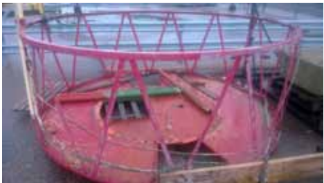
Majakkalyhty purettiin osiin. Kuvassa on majakan teräsrakenteinen huoltosilta 7.4.2014.
