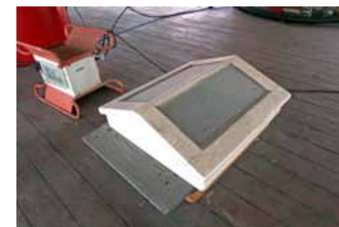
Majakkatornin etupuolinen skailetti sijaitsee hyttikannen käytävän (103) yläpuolella.
