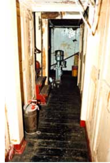
Pääkannen poikittaiskäytävä (209) vuonna 1987. Käytävän perällä on pumppu.
