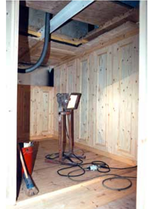
Hyttikannen hyttien seiniin asennettiin koi-vuvanerit. Kuvassa on styrpuurin puoleinen museohytti (106). Kuva: SMK / MV.
