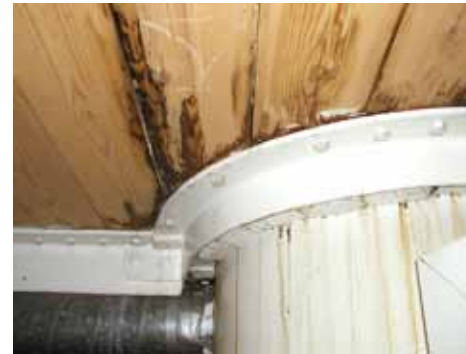
Hyttikannen ilmastointikomeron kattoa ma- jakkatornin jalan vieressä.
