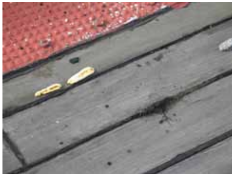
Sääkannen kansilankkujen, pääkannen seinärakenteiden lahovaurioita 21.9.–20.10.2005.
