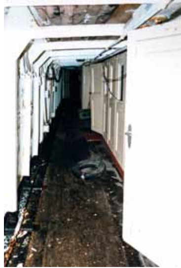
Pääkannen styyrpuurin puoleinen käytävä (205) kohti perää ennen kunnostusta vuonna 1987.
