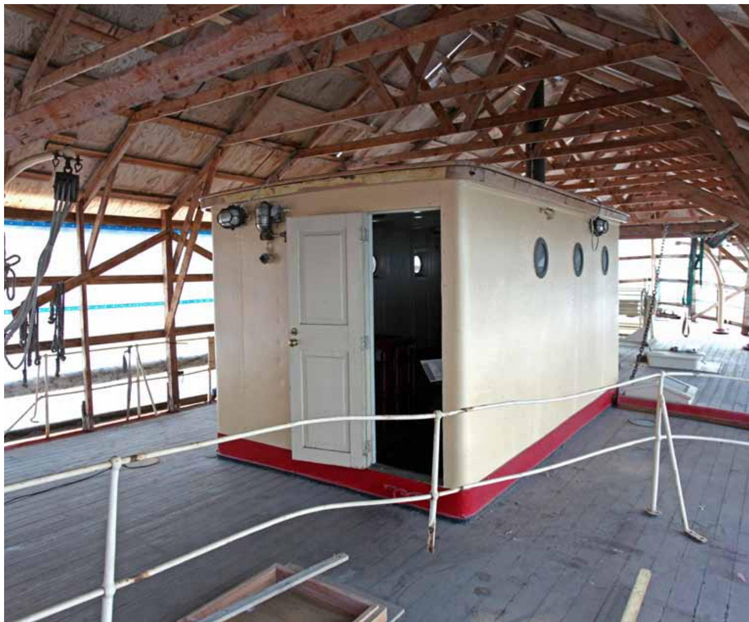
Teräsrakenteinen ruorihytti (302) on rakennettu talvella 1931–1932.
