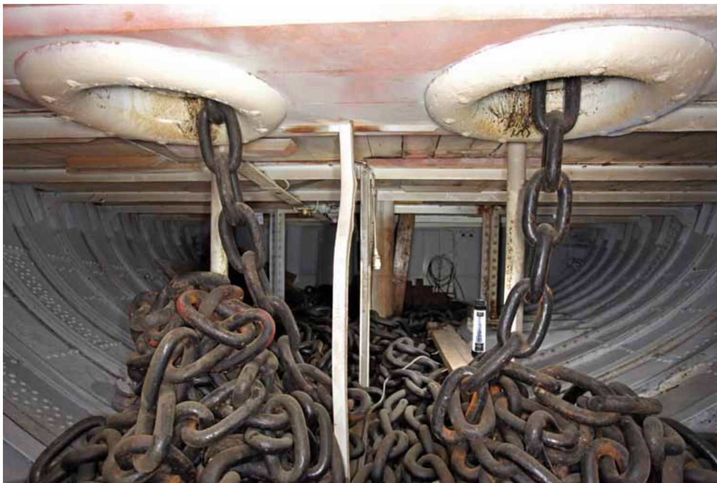
Ankkuriketjut laskeutuvat puutyöverstaan (110) läpi kulkevia klyyssiputkia pitkin kettinkisäiliöön (006). Kun ketjua ajettiin lyhemmäksi oli alhaalla kaksi miestä kiskomassa raskaita kettinkejä koukuilla syvemmälle matalaan tilaan. Voimansiirto tapahtui pääkannella sijaitsevan ankkuripelin avulla.
