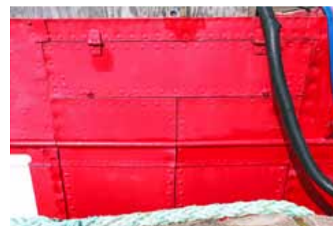
Kaksilehtisen teräsoven yläosassa on vaakasuoraan aukeava kolmas osa.
