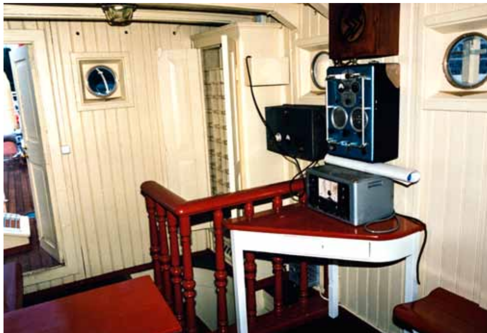
Ruorihytti kunnostuksen jälkeen vuonna 1988. Portaassa on uudet sorvatut kaidetolpat.
