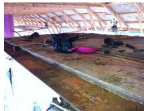
Ohjaushytin kattoa korjattiin vuonna 2012. Kuvat: SMM, käsiarkiston digitaaliset aineistot.
