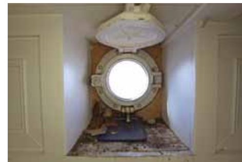
Asuintilojen ulkoseiniä on eristetty 1980-luvulla.
