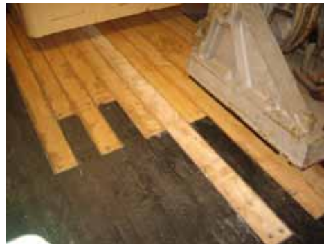
Pääkannen uusia männystä valmistettuja kansilankkuja asennetaan. Kuvat on otettu 5.11.2007.
