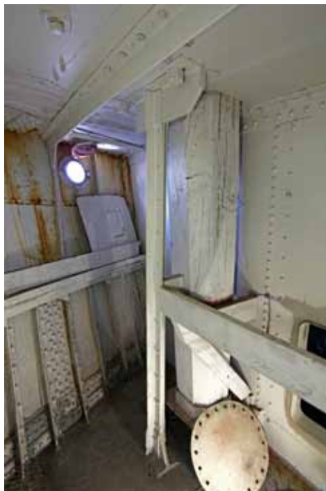
Vesivarastossa (111) on kaksi kahdeksankulmaista tammipilaria, jotka kantavat kahta yläpuolista kiinnityspollaria.
