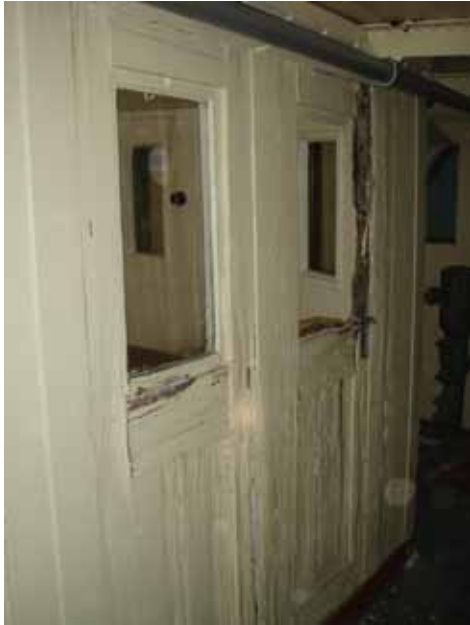
Miehistömessin (210) seinää paapuurin käytävän (203) puolelta.
