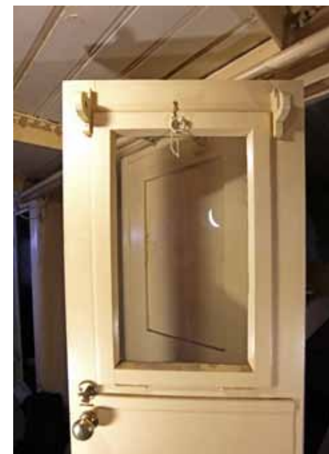
Peiliovessa on alhaalta saranoitu aukeava ikkunaosa.
