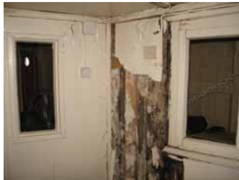
Sääkannen kansilankkujen, pääkannen seinärakenteiden lahovaurioita 21.9.–20.10.2005.
