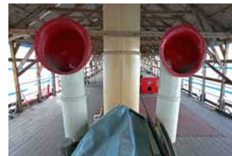
Kuva keulaan päin. Konehuoneesta (002) nousevia raakitorvia voi kääntää vallitsevan sään mukaan. Niiden välissä on höyrykattilan savutorvi eli korsteeni.
