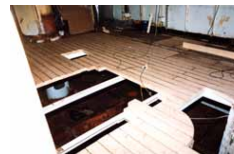
Uudelleen tehtyä kansirakennetta pääkannen päällystömessissä (208), jonka perän (vasemmalla) ja paapuurin (kuvassa oikealla) puoleiset väliseinät on purettu. Oikealla on hyttikannen käytävälle (103) johtavan portaan aukko. Kuva: SMK / MV.
